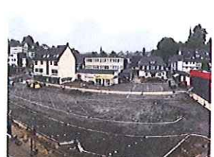
Baufirma pflastert im Rekordtempo
